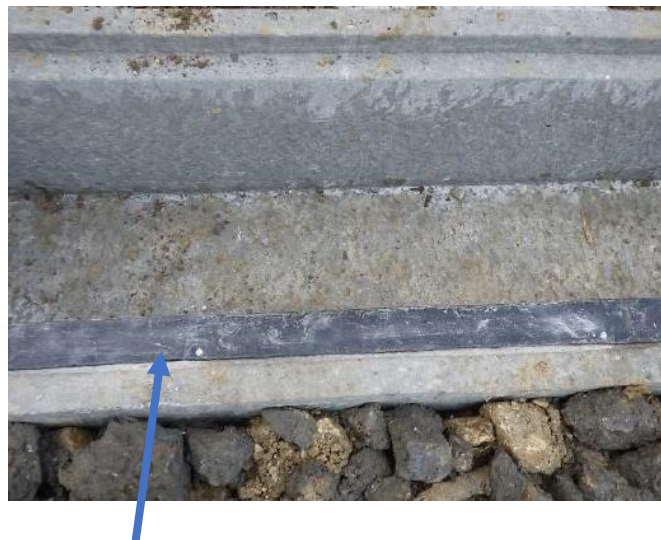
Pose d'une bavette en caoutchouc de 8cm de largeur environ pour empêcher que les amphibiens n'escaladent les fissures potentielles et sortent du U
