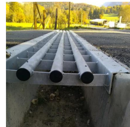
Passage canadien spécifique permettant le passage des engins mais pas des amphibiens
