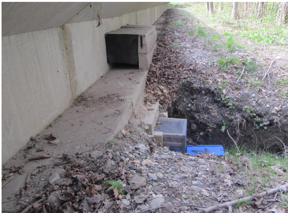
Passage à petite faune du Cheylas: bavette pour empêcher la rainette de grimper
